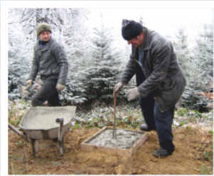
Założenie fundamentu pod krzyż na Szubienicznym Wierchu. Źródło: Archiwum Zjednoczenia Łemków
