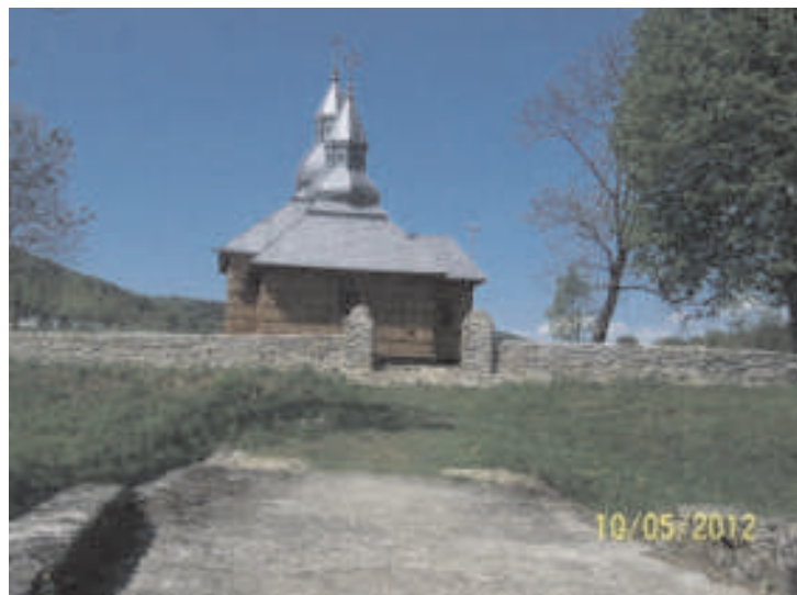
Olchowiecka cerkiew po pracach remontowych
