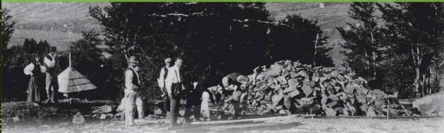
Początki budowy kaplicy 1929 r. Zdj. z publikacji Stefana Kuryty pt.: Objawienia Preczystoj Diwy na hori Jawir, Yonkers 1993
