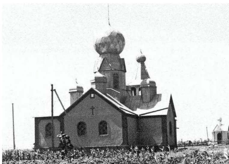
Cerkiew prawosławna w Wasyliwce (Mykołajowski Obwód). Fot. M. Pecuch.
