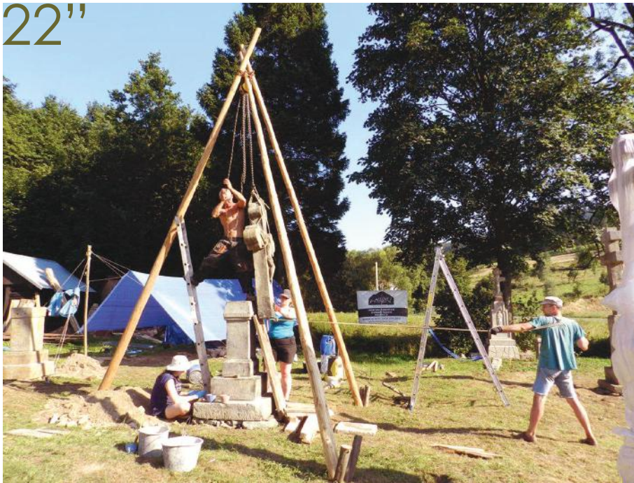
Ремонт старого цмонтеря в Пантні - VIII 2015
