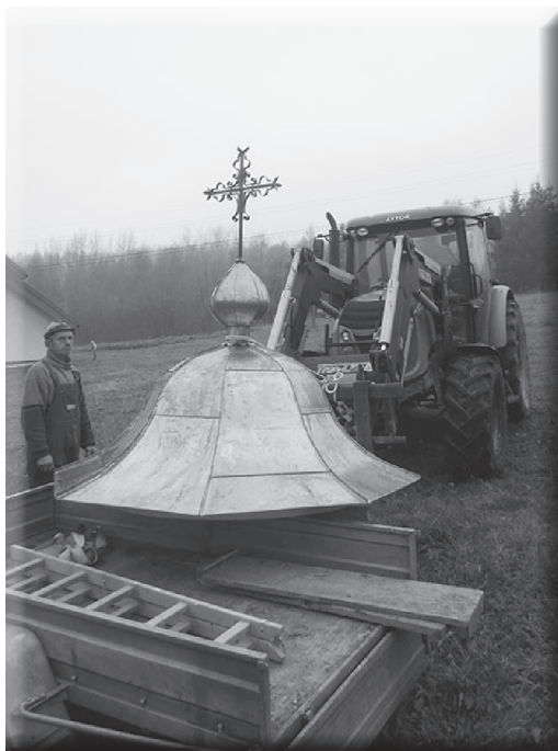
Граб. Монтаж мідяного даху в жовтні 2015 р.
